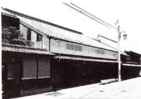
写真1. 室内を改造した町家の外観
